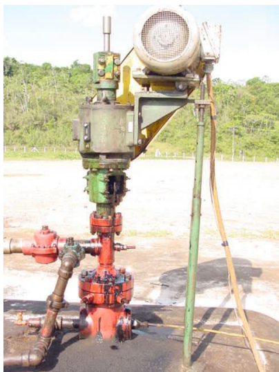
Figura 2.1: Poço com BCP.
