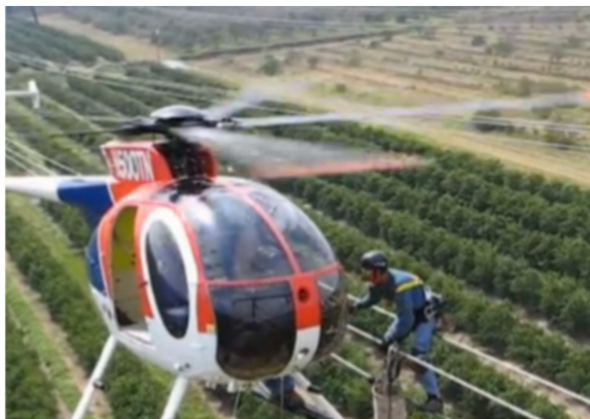
Figura 3 – Manutenção realizada a partir de aeronave, [SENAI - CIMATEC, 2013].
