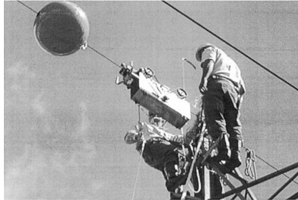
Figura 7 – Teste realizado em campo para remoção e instalação de esferas de sinalização, [CAMPOS et al., 2002].
