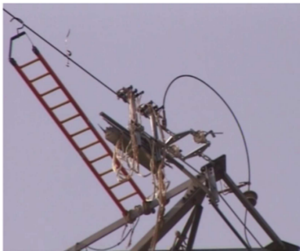
Figura 14 – Teste de robô de inspeção no cabo guarda, [LI; RUAN, 2010].
