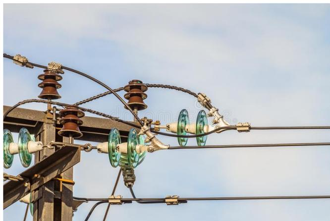
**Figura 6** – Posição de montagem dos isoladores: Isolador de porcelana montado como apoio e isolador de vidro montado como suporte. Adaptado de [28].
