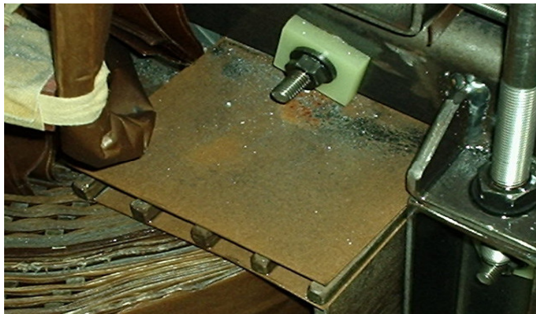
Figura 2.12 - Partículas sólidas encontradas no interior do OLTC
