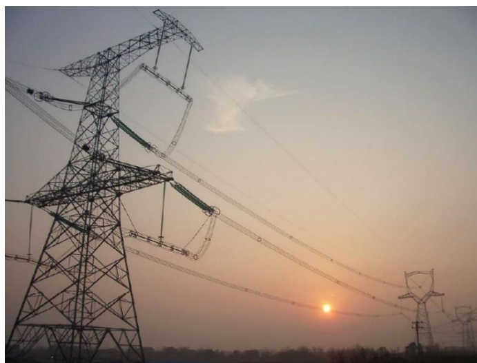
Figura 4. Seção de linha de teste de circuito único da base de teste UAT CA no Wuhan High Voltage Research Institute .
