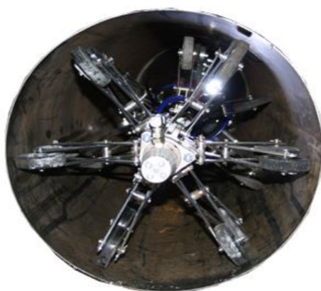
Figura 2.8: Robô utilizado em procedimento de reparo em um tubo com corrosão interna. Fonte: [15]
