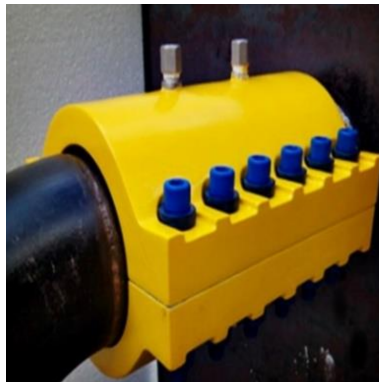
Figura 2.4: Braçadeira de material composto (em amarelo) instalada em volta de tudo com corrosão externa (em preto). Fonte: [15]
