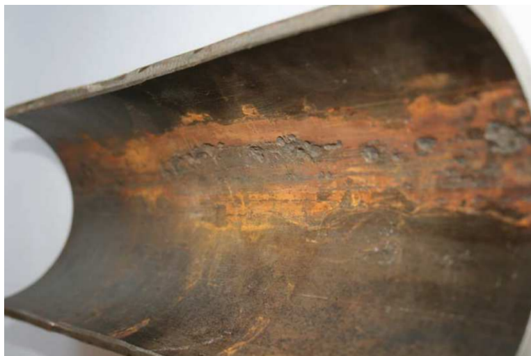
Figura 2.2: Tubo com corrosão interna por CO_2 . Fonte: [14].
