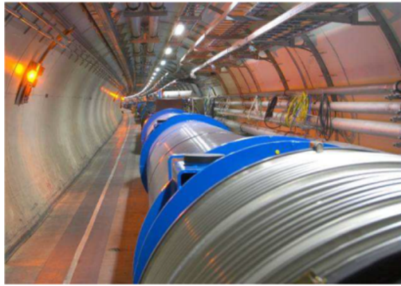
Figura 2.3: Fotografia do túnel do LHC [32].
